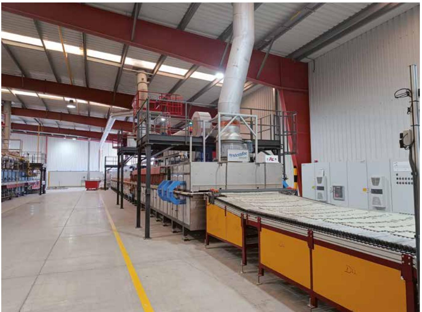
Figura 4.18. Forno elétrico para cozedura de cerâmica de pavimento/revestimento instalado na empresa Equipe Cerâmicas [37].
