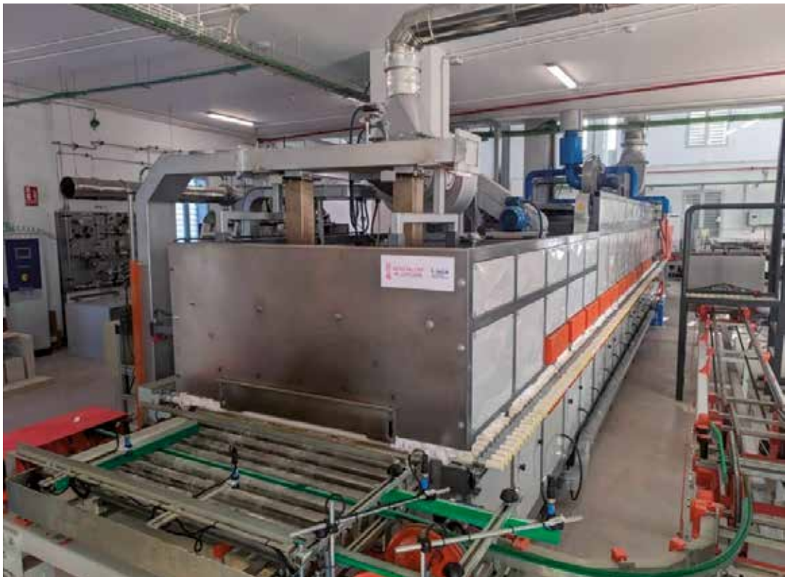
Figura 4.17. Vista geral do forno elétrico (zona de entrada de material).
